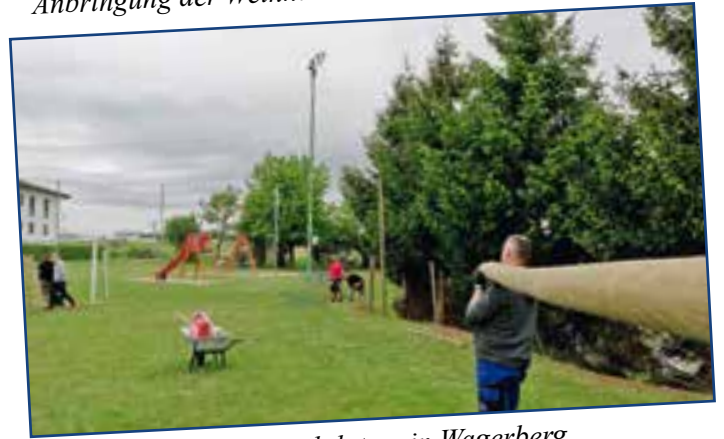
Instandsetzung des Spielplatzes in Wagerberg
