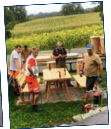
Errichtung eines Rastplatzes in Haller im Rahmen der Gartentour
