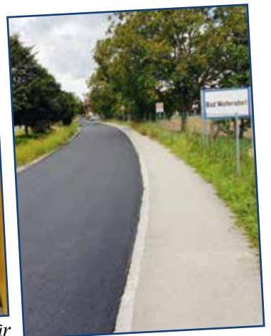
Sanierung der Hintergasse.
