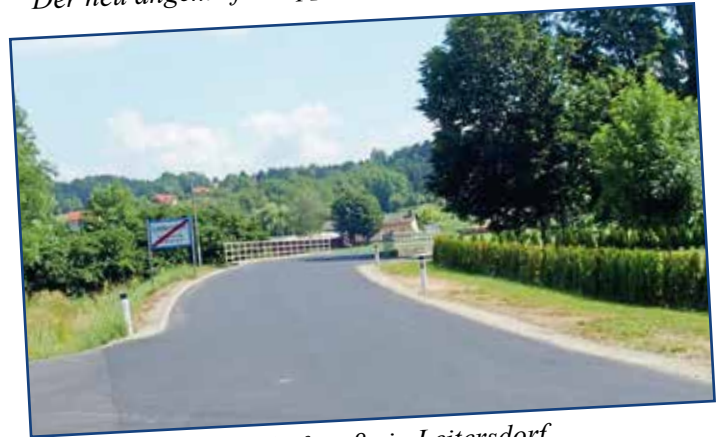
Sanierung der Bahnhofstraße in Leitersdorf.
