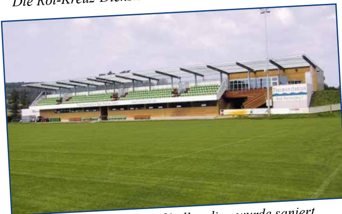
Das Hauptspielfeld im Fußballstadion wurde saniert.
