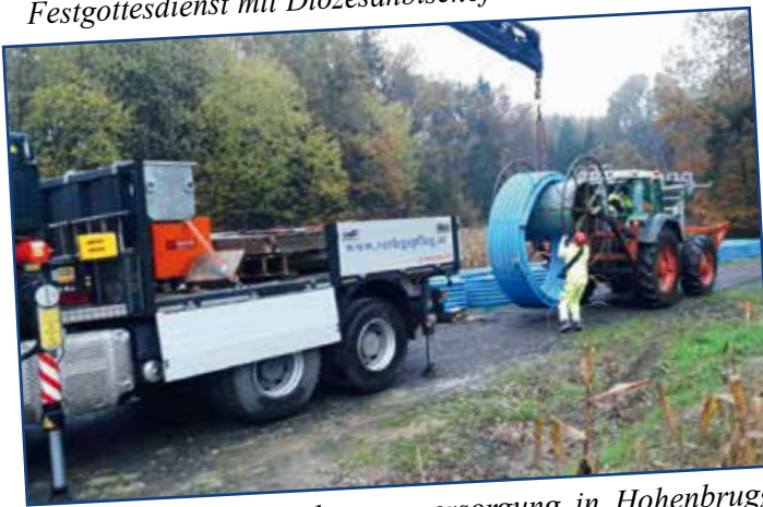
Der Ausbau der Trinkwasserversorgung in Hohenbrugg konnte abgeschlossen werden.
