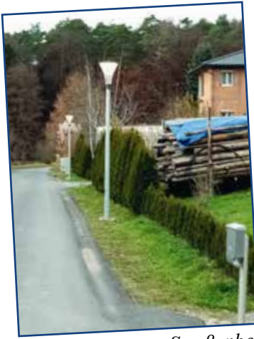
Errichtung einer Straßenbeleuchtung in Steinfeld.
