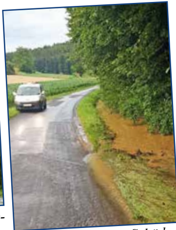
Beseitigung von Schäden durch Unwetter.
