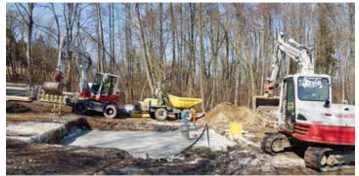
Die Arbeiten sind im vollen Gange!
